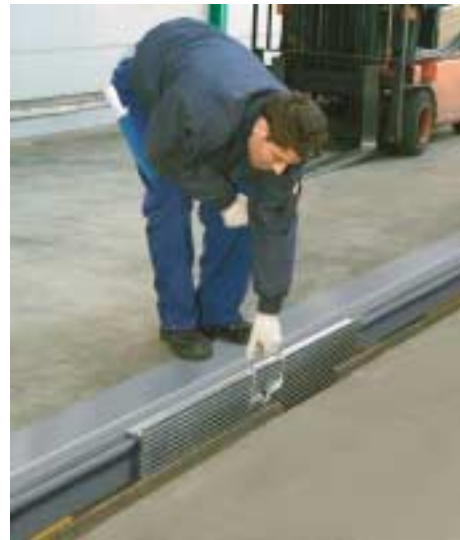
BB-Brücke aus der Führungsschiene herausheben.
